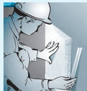
Fig. 9b : Pose de profilé vertical
